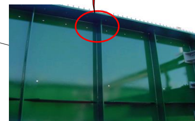
日本道路公団時代 駒瀬川橋梁への腹板孔明けおよびシリコンプラグ取付状況
