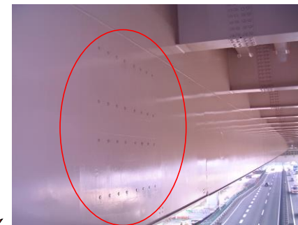
H14.4 日本道路公団名古屋建設局 有松高架橋へのシリコンプラグ設置状況
