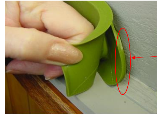
Step-2 化粧板をめくりえら部の挿入状況を確認します。
