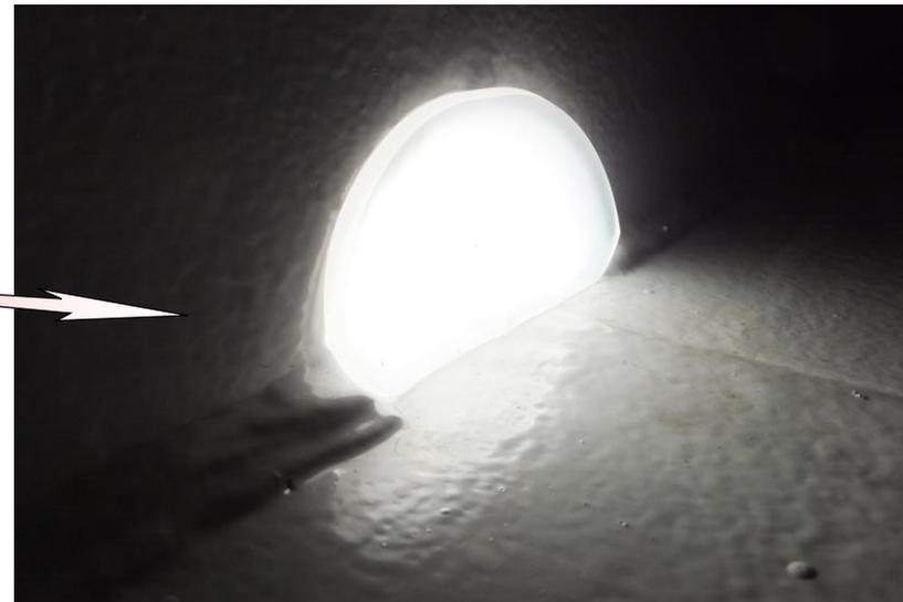
スカーラップを鋼板または着色キャップ等で閉塞すると箱桁内は暗闇となります。高透明のシリコン材で閉塞すると写真のように明るくなります。箱桁内の塗装系は紫外線に弱い内面仕様となっています。採光したことによって塗膜が劣化しないことを確認しておく必要があります。現在、紫外線対策用の製品を開発中である。
