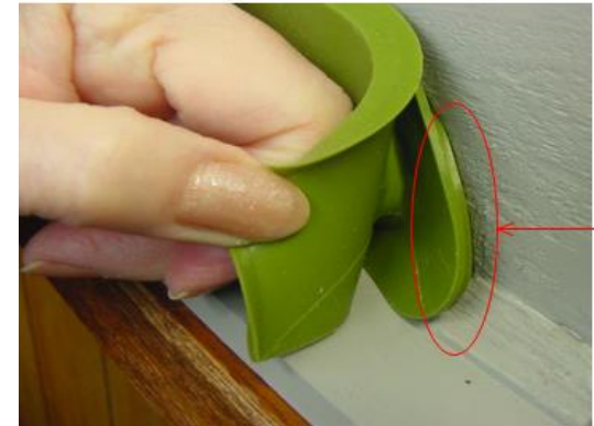
Step-2 化粧板をめくりえら部の挿入状況を確認します。
